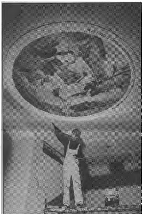
Die kostbaren Deckengemälde haben durch den Wasserdampf stark gelitten, daneben sind auch diverse Malerarbeiten zu machen.
